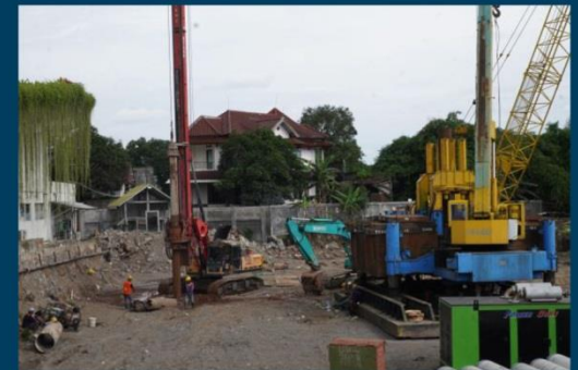
MATARAM CITY (TOWER ARJUNA DAN BIMA) - TAHAP PEMBANGUNAN
